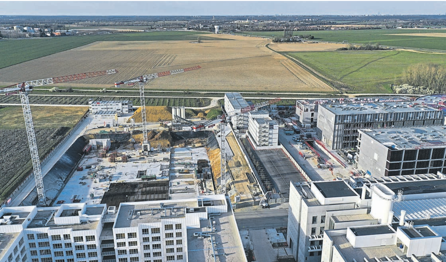
Construction d'un groupe scolaire, de logements familiaux et de bureaux pour le centre de recherche et innovation Danone Research, dans le quartier du Moulon de la communauté d'agglomération Paris-Saclay, dans l'Essonne. Photo Laurent Grandguillot/Rea
