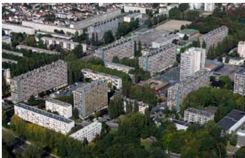
Copropriétés dégradées Clichy-sous-Bois - copyright Ph. Guignard
