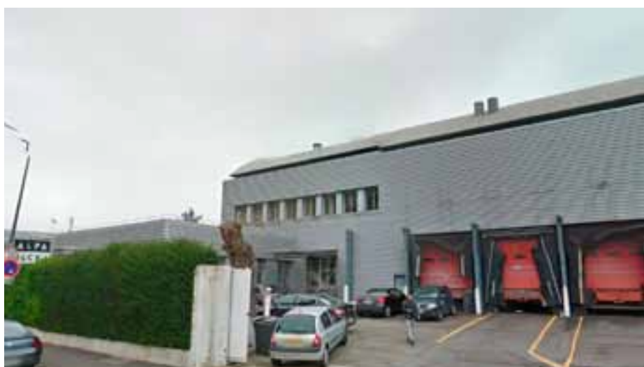
Zone de stockage totalisant 5 300 m 2 (espace bureaux d'environ : 1 338 m 2 , magasin et show-room : 164 m 2 , locaux techniques : 38 m 2 , emplacements de parkings privatisés).
