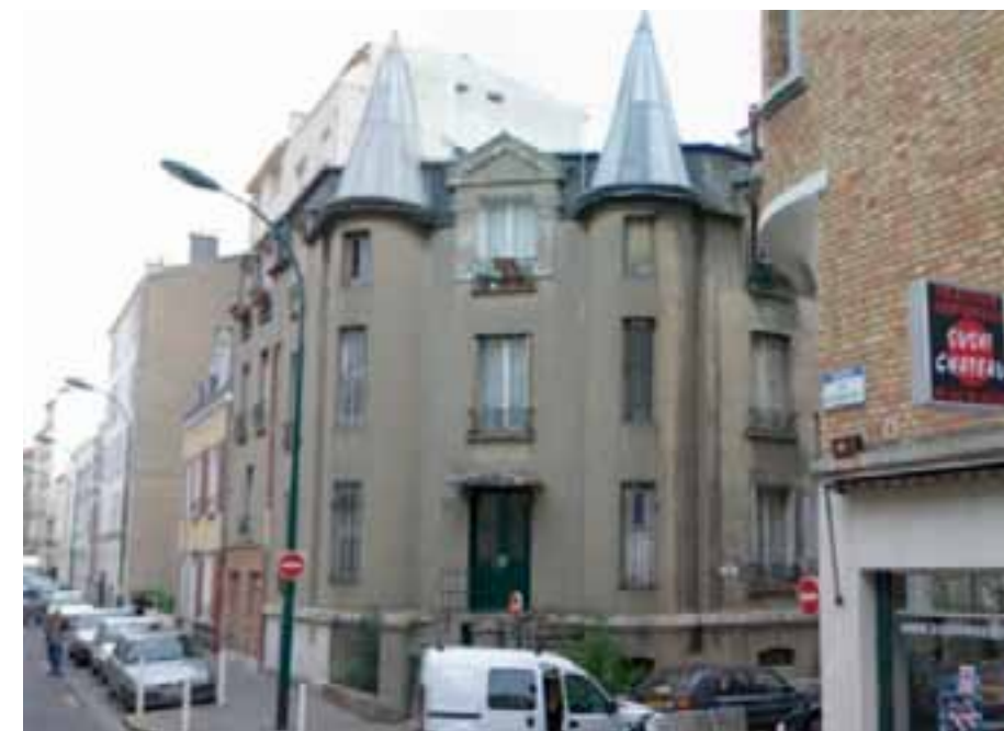
La ville de Vincennes a demandé à l'Établissement de mener la réhabilitation et l'acquisition de 12 logements sociaux. Le prix de l'opération était trop élevé pour le bailleur social auquel il a été consenti un bail emphytéotique de 51 ans pour étaler la charge.
