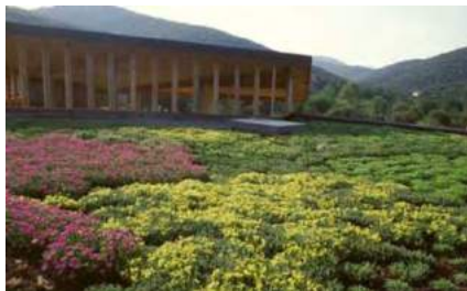
Toiture végétalisée semi-extensive
