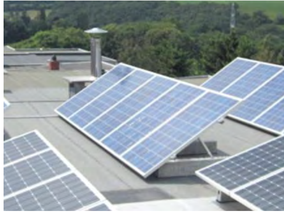
Figure 29 - Installation non intégrée au bâti
