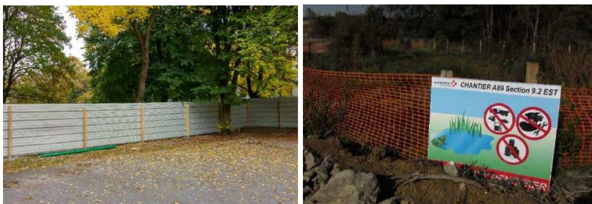
Figure 152 : Exemple de panneaux et grillage orange à mettre en place durant la phase de travaux (Source : ECOTER, 2017)
