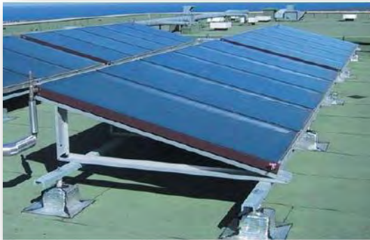
Figure 15 - Capteurs solaires thermiques installés en toiture terrasse avec plots de fixation
