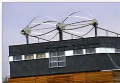
Eolienne de type Darrieus
