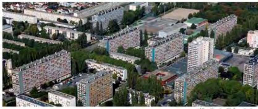
Figure 147 : Copropriété (Source : GoogleEarth)
