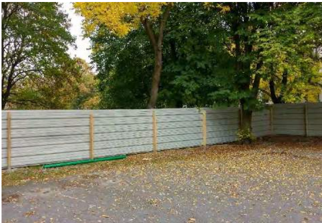
Barrières de type panneaux à disposer au niveau des limites entre les zones de chantier et les secteurs préservés du bois de la Lorette et de la Boucle de Sévigné.
