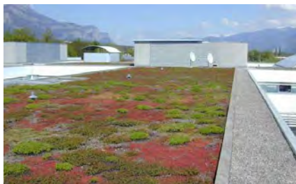
Toiture végétalisée extensive
