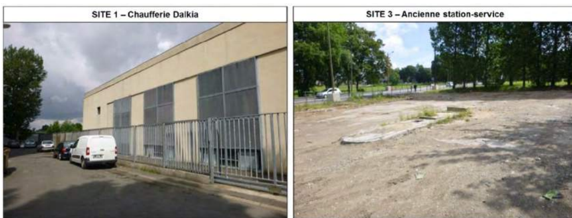
Figure 57 : Photographies des sites 1 et 3 (Source : étude BS Consultant)
