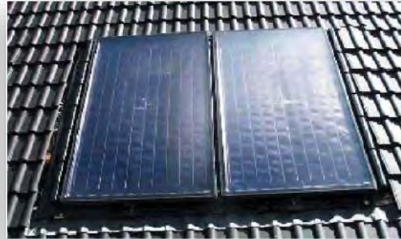
Figure 14 - Capteurs solaires thermiques intégrés à une toiture inclinée
