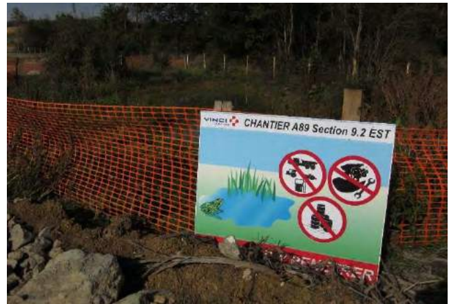
Barrière de type grillage orange à positionner autour des arbres prévus d'être préservés et panneau d'information à disposer au niveau des barrières de chantier protégeant le bois de la Lorette et la friche de la boucle de Sévigné.
