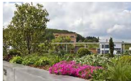
Toiture végétalisée intensive
